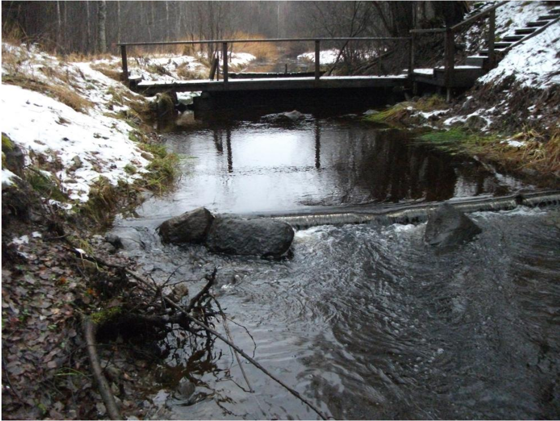
Damm och bro innan åtgärd
