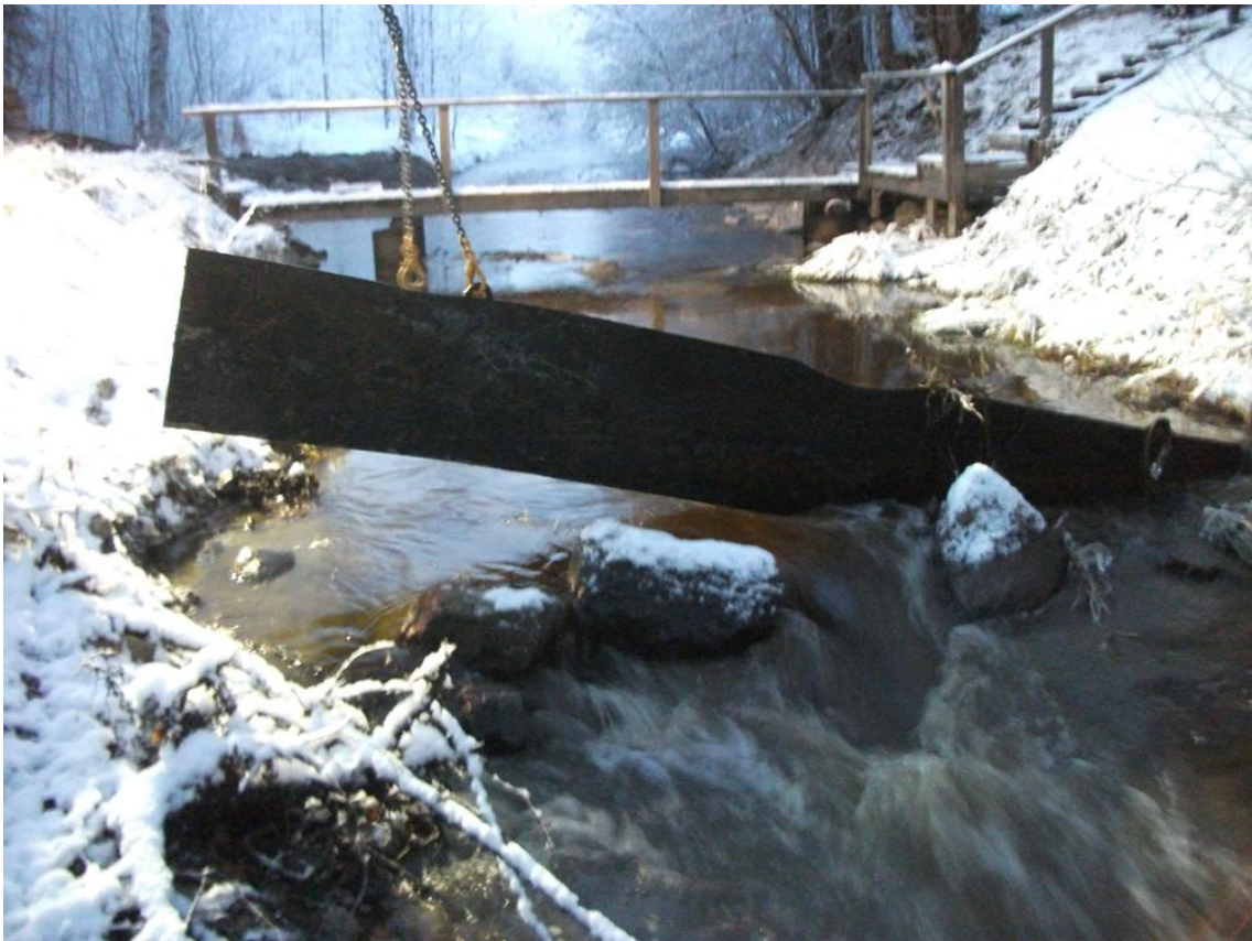
Rivning av damm
