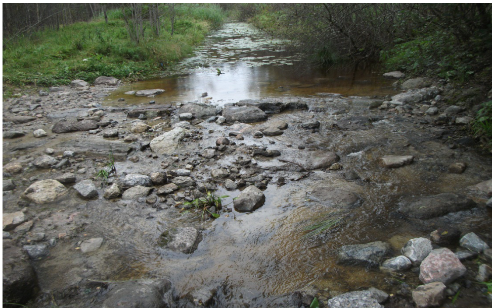
Hillesjöns utlopp-Kanalen i bakgrunden hållersjönivå. Stora block ligger under tätningsfraktionerna. Lågvattenutskov till höger i bild.
